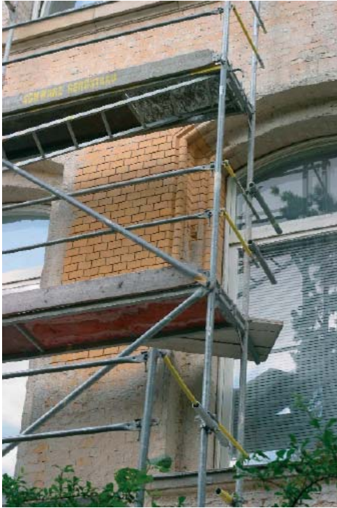
Musterfläche zur Fassadensanierung
